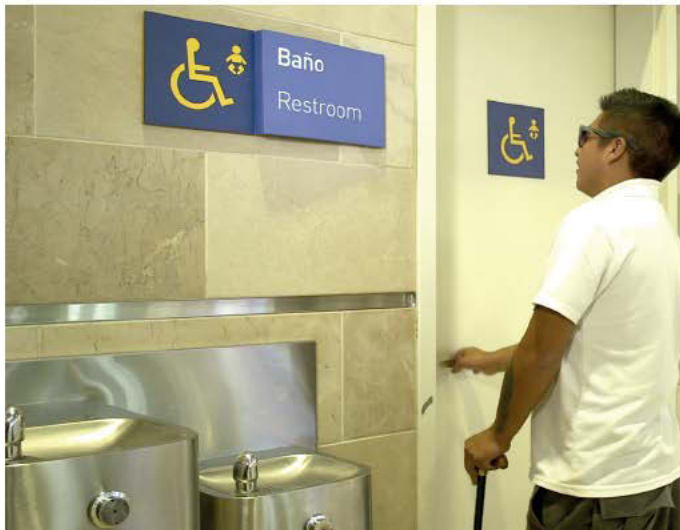
Baños habilitados aeropuerto. Quito, Ecuador.
