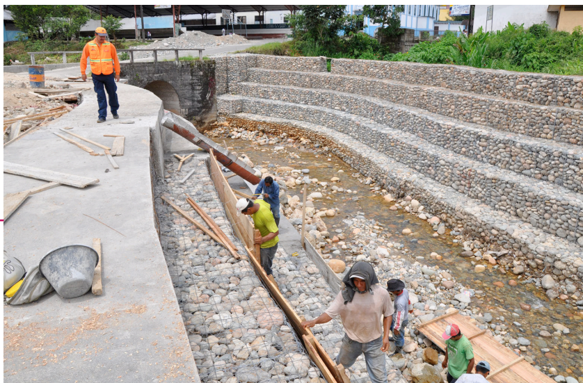
Obra de emergencia en el Tena.
