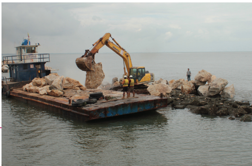
Obra de prevención muro de escolleras en el litoral ecuatoriano.
